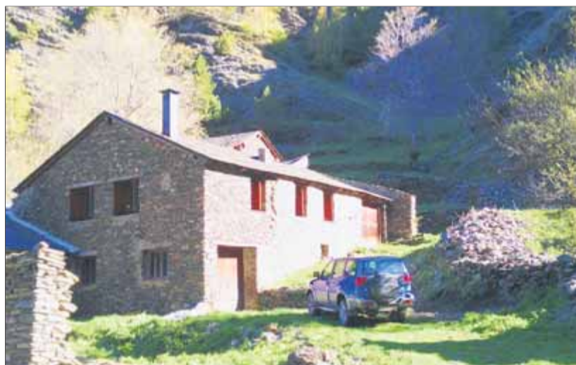
Després de diversos mesos de treballs de rehabilitació, Casa Sansa torna a obrir ara les seves portes com a habitatge turístic ■ TOR EXPERIENCE
