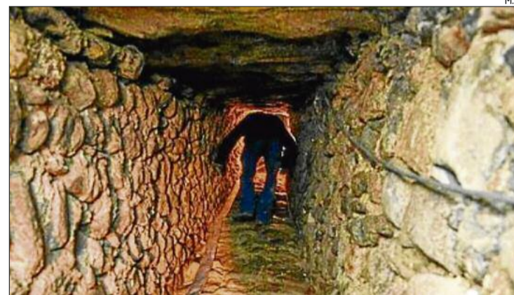
El túnel que porta a la galeria Ull de Basilisc.
