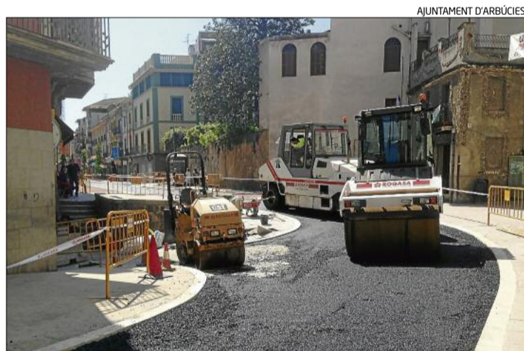
L'asfaltatge es farà als carrers Camprodon i Pont.
