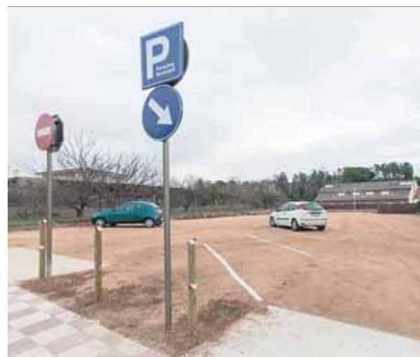
Una imatge de l'aparcament de Santa Coloma, al carrer Argiles, obert fa uns dies ■ D.R. / AJUNTAMENT DE STA. COLOMA
