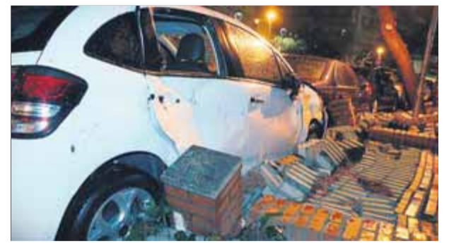
El mur d'un hotel de Salou va caure sobre els vehicles que estaven estacionats com a conseqüència de l'aiguat ■ ACN
