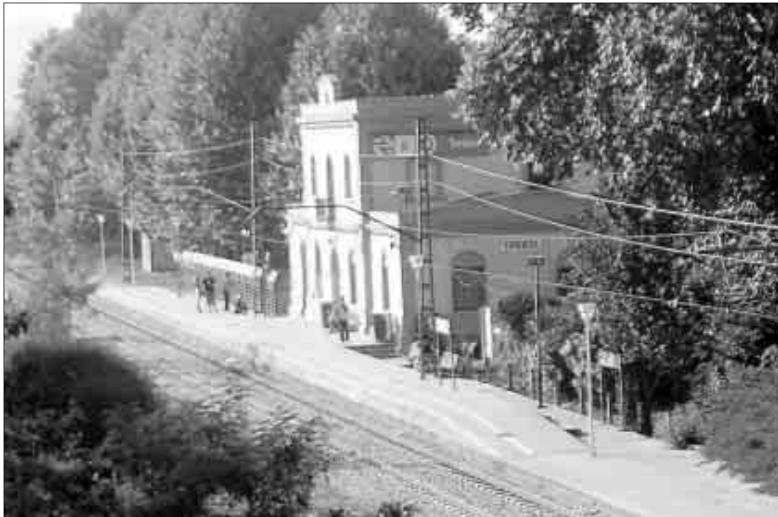
ESTACIÓ. Un nou servei d'autobús permetrà que els veïns es puguin desplaçar fins aquest indret.
