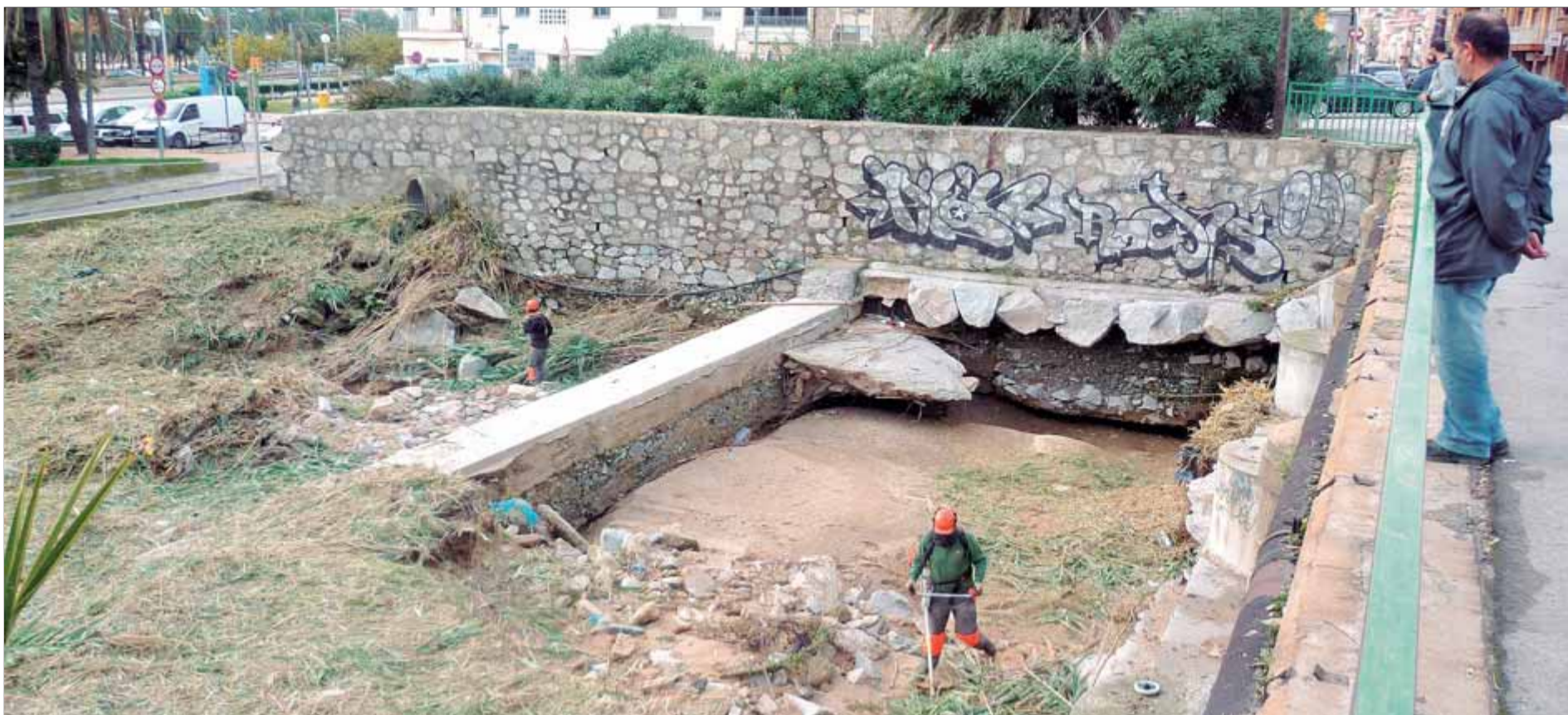
Un operari duent a terme tasques de manteniment a la riera de Sant Simó de Mataró ■ LLUÍS MARTÍNEZ
