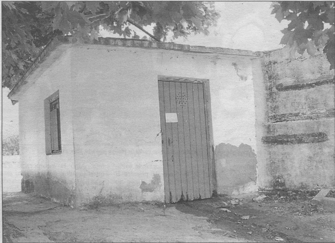
La caseta on hi ha les instal·lacions de l'aigua de Les Ferreres, que ahir estava precintada. Foto: LLIBERT TEIXIDÓ.
