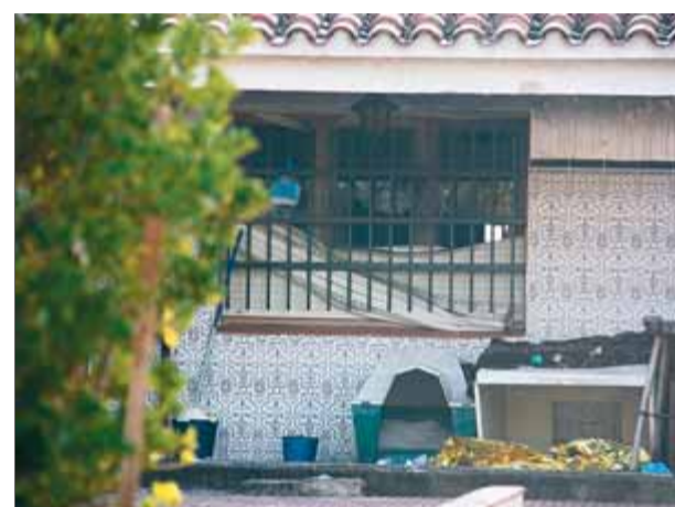
La casa de la urbanització Àgora Parc de Tordera on va morir una dona com a conseqüència d'un incendi ■ L.V. / ACN
