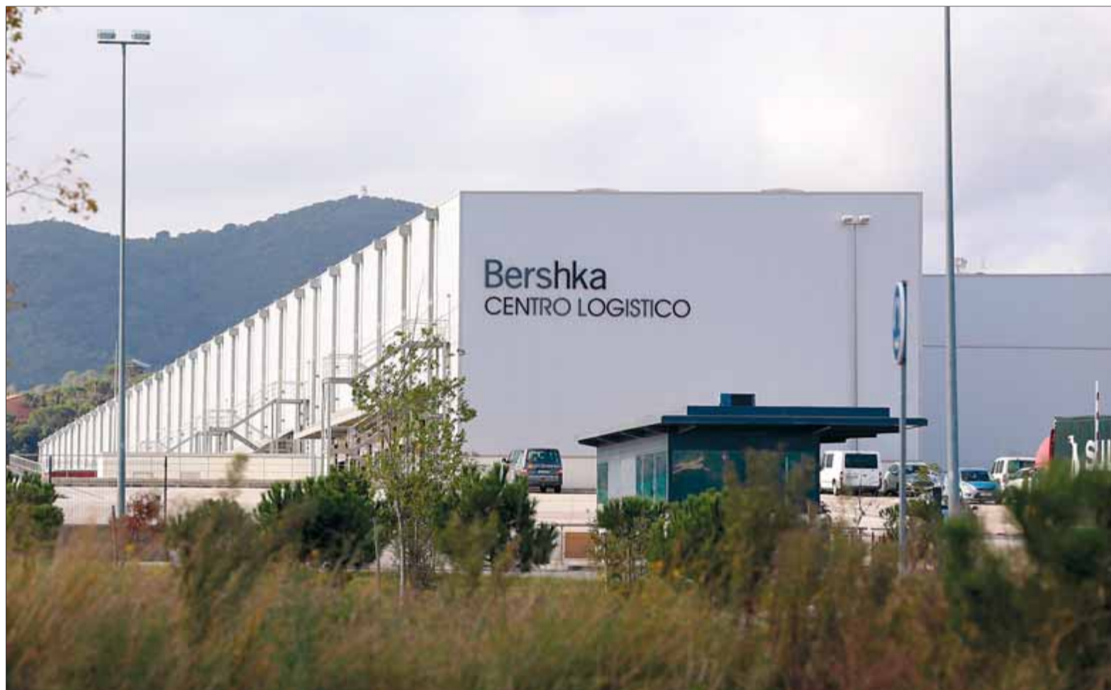
La seu del centre logístic Bershka al polígon industrial de Palafolls on es vol construir un nou espai d'emmagatzematge ■ QUIM PUIG
