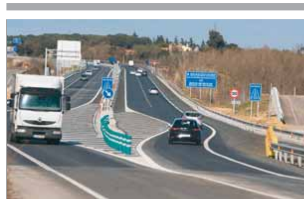
El final del tram desdoblament de Caldes a Sils de l'N-II. Els treballs al tram Sils-Maçanet ja han començat ■ LL. SERRAT
