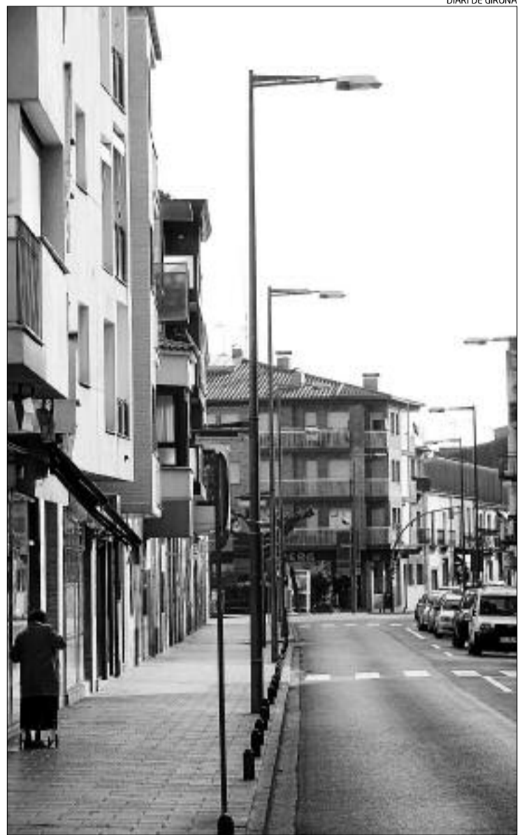
Part de l'enllumenat públic de Santa Coloma es renovarà.
