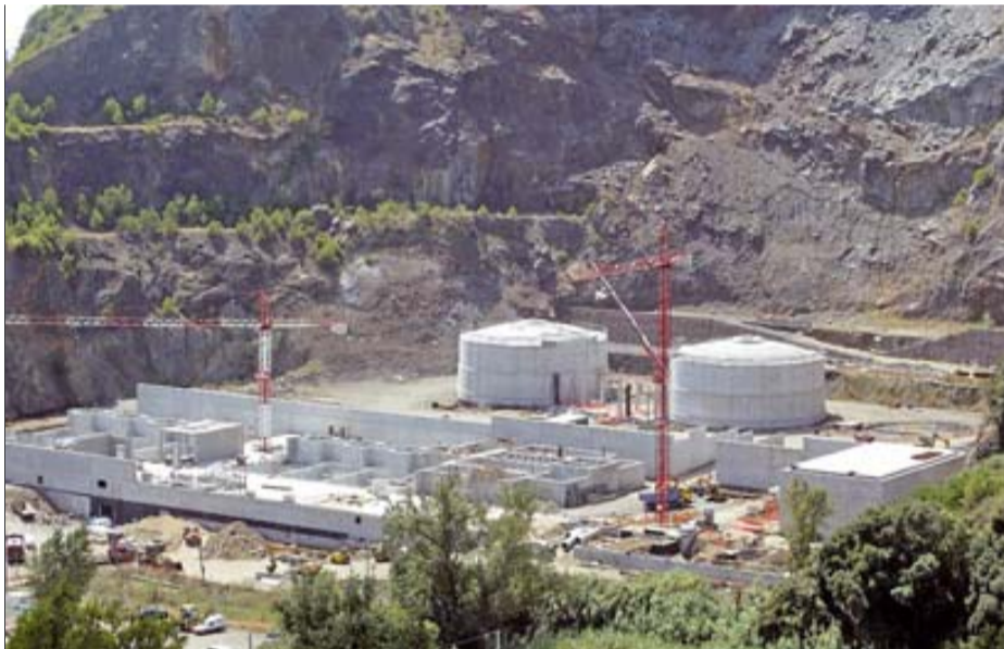
Obres de la depuradora de l'Alt Maresme, a l'antiga pedrera de Montpalau ■ J.R.
