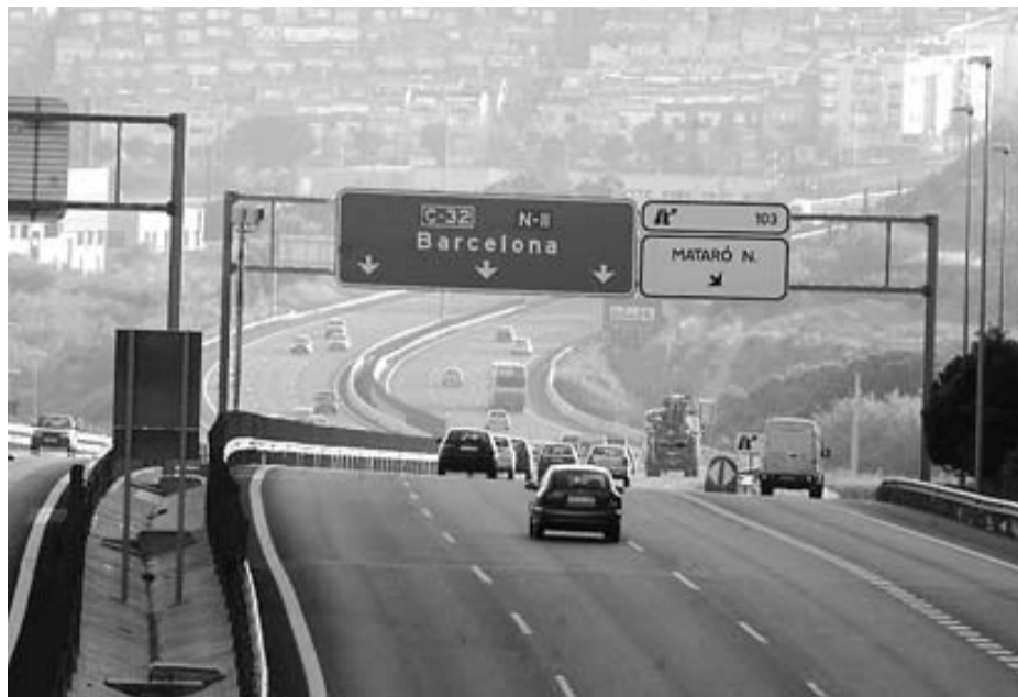
La futura ronda de Mataró es construirà a banda i banda de l'actual autopista C-32. / Q. PUIG
