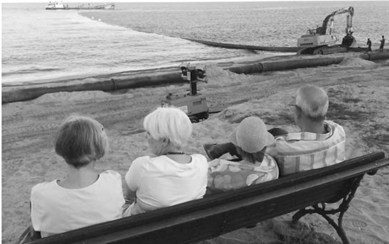
La draga, aquest estiu passat, treballant i reomplint de sorra la platja de la Picòrdia d'Arenys de Mar. / E.F.
