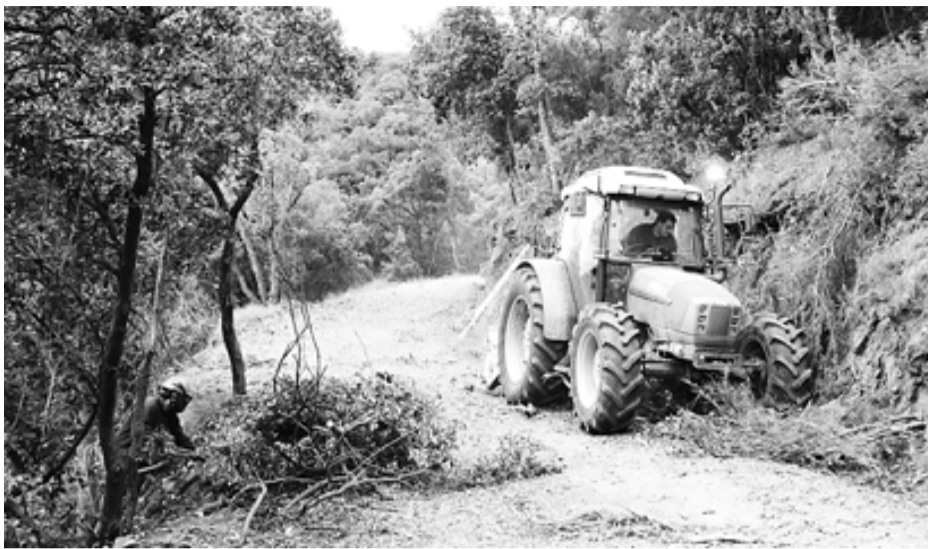
Dos tècnics desbrossen el bosc del Montnegre i el Corredor al terme de Tordera. / T.M.
