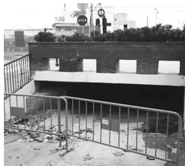
Imatge d'arxiu del rial del Bareu, en obres. / EL PUNT
