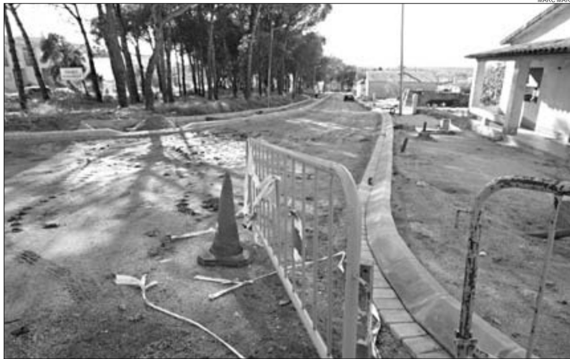
En obres. La rotonda que s'està construint acabarà amb un dels punts negres d'accés a la localitat.
