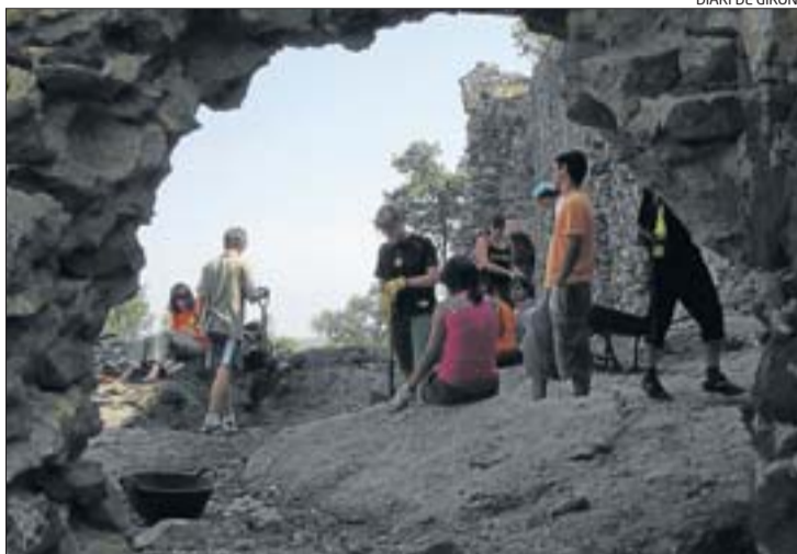
La muralla de l'antiga fortalesa està sent restaurada.
