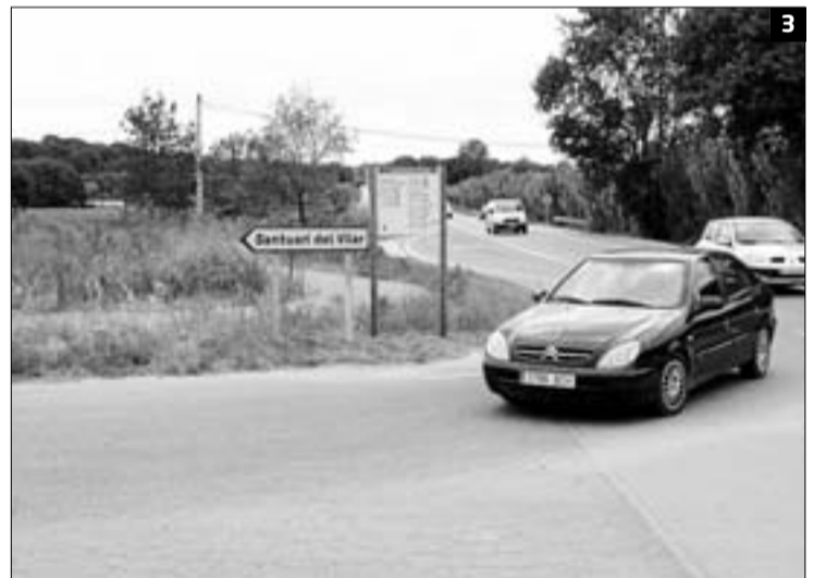
► ELS PROJECTES 1 El PEIN dels Prats d'en Gai resulta afectat pel corredor de carreteres. 2 Les estaques marquen el pas de les carreteres a prop del PEIN. 3 La via es perllongarà sota el nom d'A-2 pel Vilar de Blanes.
