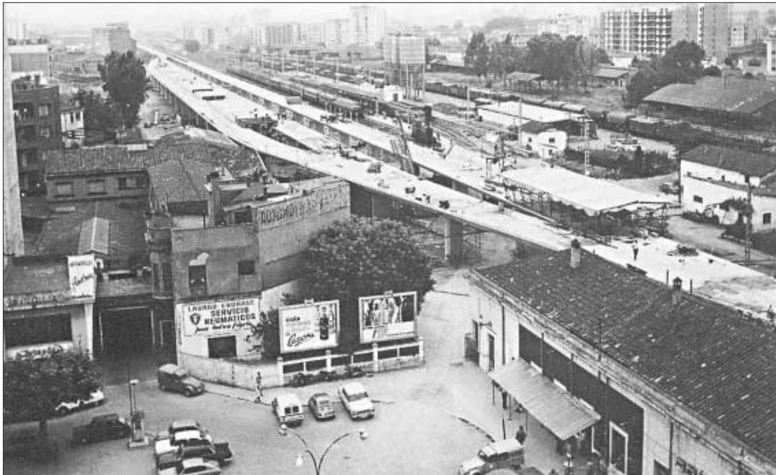
El viaducte. Una imatge dels treballs que van servir per aixecar la via del tren al seu pas pel centre de Girona i fer per la nova estació de Renfe.
