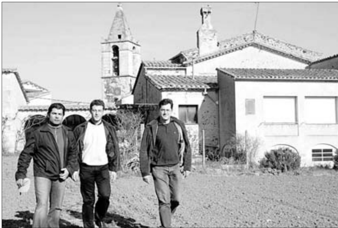
ADQUISICIÓ. El Bisbat i l'Ajuntament han arribat a un acord per poder donar un ús a l'edifici.
