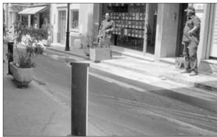
COL·LOCACIÓ. S'estan posant a cada costat del carrer.
