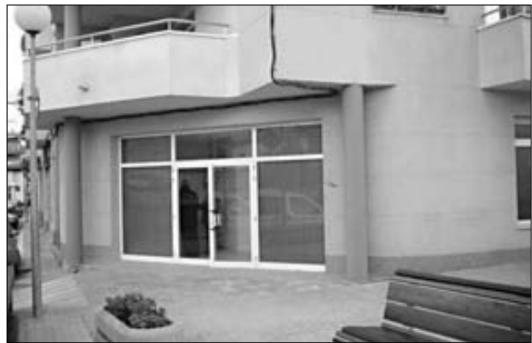
Nou equipament. El centre de rehabilitació respondrà a una necessitat local.
