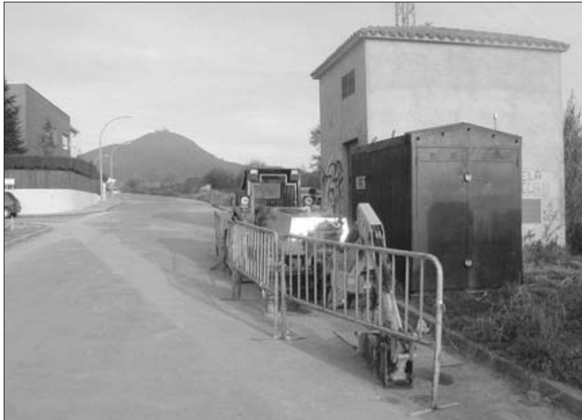
Carrer amb obres. Els projectes urbanístics de Breda han canviat de mans amb l'entrada de la Crida al govern local.
