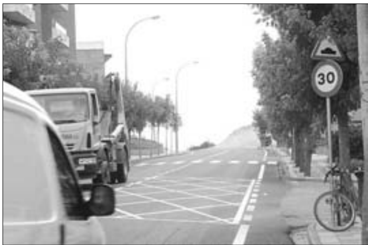
VIANANTS. S'indica que hi han passos elevats, però han desaparegut.
