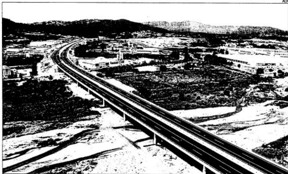
Viaducte del nou tram de la C-32 entre Tordera i Palafolls.
