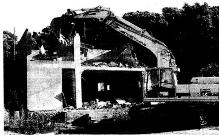
La grua va enderrocar ahir l'estructura de l'habitatge, on no hi vivia ningú. / T.M.
